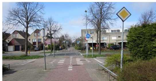
afbeelding 16 Borden B1 kunnen worden verwijderd
