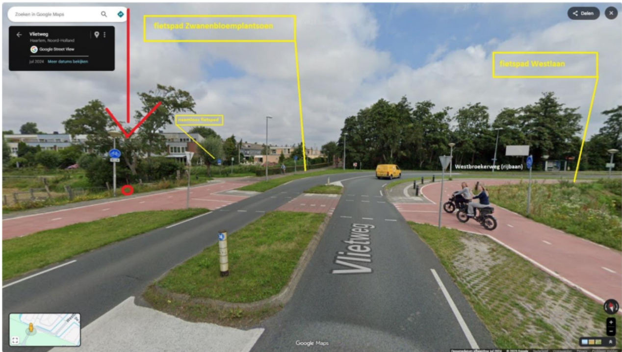
Foto Foto 2024: Aansluiting fietspad Zwanenbloemplantsoen op fietspaden Vlietweg/Westlaan. Hier ontbreekt bewegwijzering.
