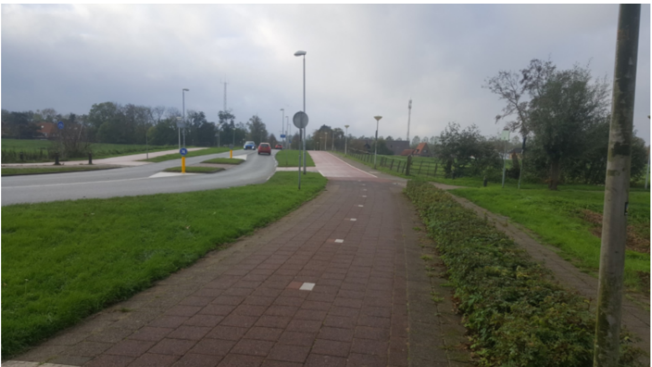
Foto oktober 2025: Aansluiting op Vlietweg net na kruising met de Westbroekerweg (Fietspad langs de Westbroekerweg, eigen naam is Westlaan) overgang tegels-betonplaten
