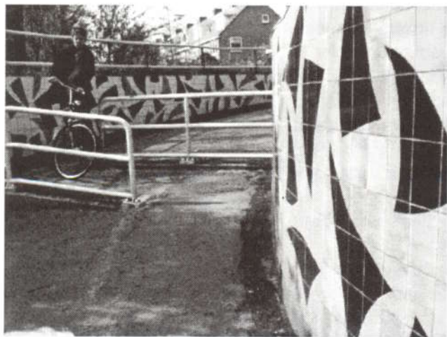
Munterslaan-Randweg tunnel. Aan de randen is asfalt weggevreten, vieze modderboel. Oppassen dat je je fietsband niet beschadigt bij het zigzaggen om de hekjes heen. Hinderlijke onnodige hekjes, er kan een apart voetgangersgedeelte gemaakt worden.
