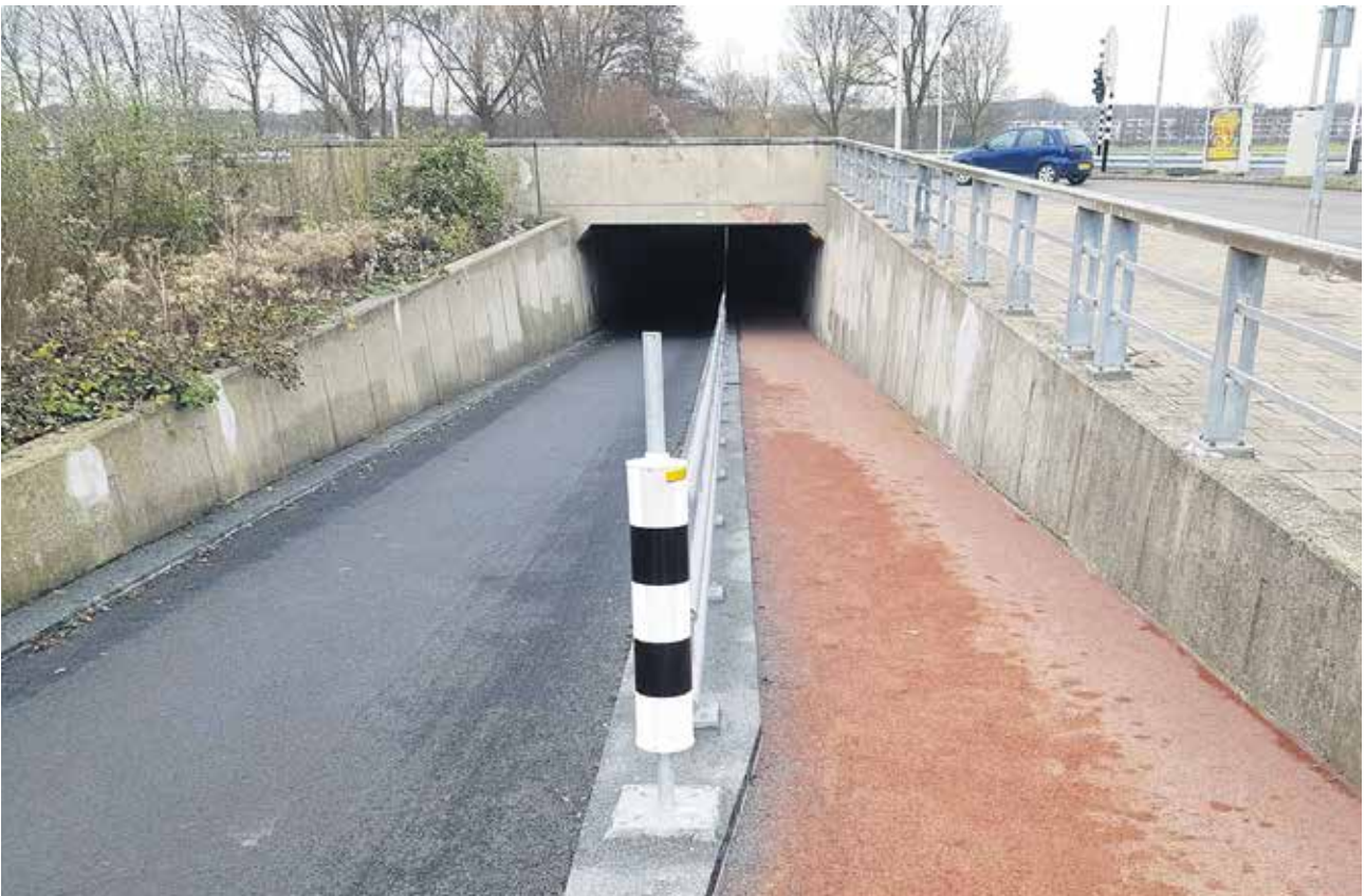
Tunneltje Westelijke randweg: links het fietspad in donkergrijs asfalt, rechts het voetpad in rood asfalt.
