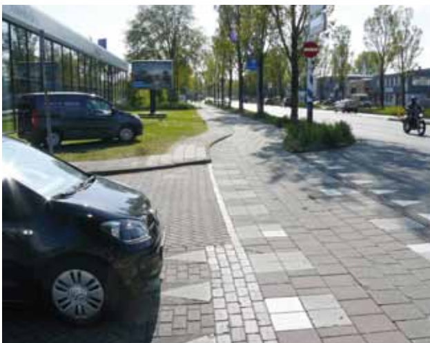
Oudeweg - één van de zijwegen. Het fietspad wordt beveiligd met een asfaltdrempel.
