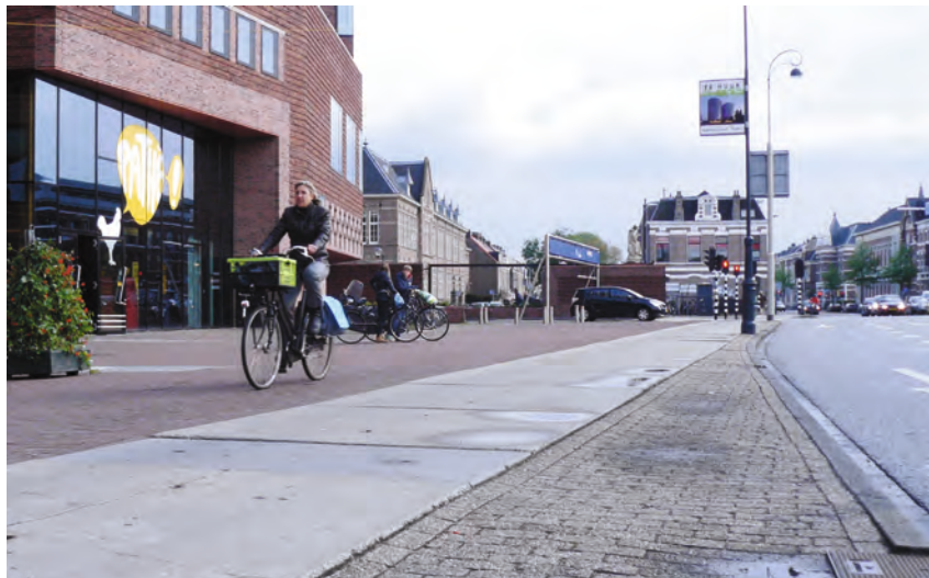
Zijlvest 13-05 Wachten op rood asfalt. Fietser gaat liever over de klinkers dan over de betonplaten
