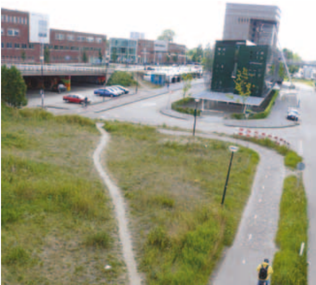
De oude situatie waarbij het fietspad met verschillende bochten naar het station Spaarwoude loopt.
