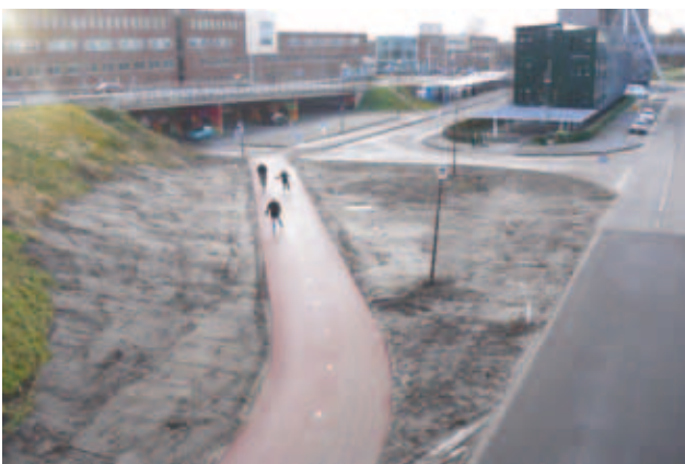
het foutief aangelegde nieuwe fietspad dat het spoor van het olifantpad volgt.
