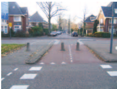
Onlogische plaatsing van de paaltjes op de doorsteek Heemstedse Dreef - Postlaan.
