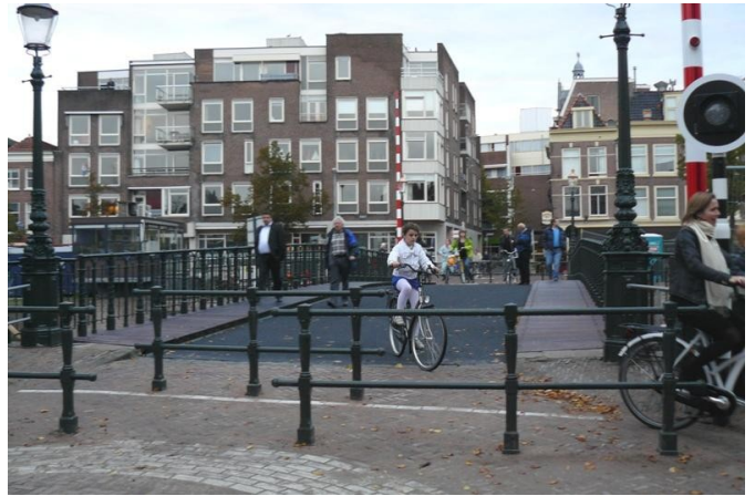
Melkbrug na de renovatie – situatie 5 oktober 2010. Een week later is door ingrijpen van wethouder Van Doorn het middelste hekje verwijderd. (Foto Jaap Moerman)
