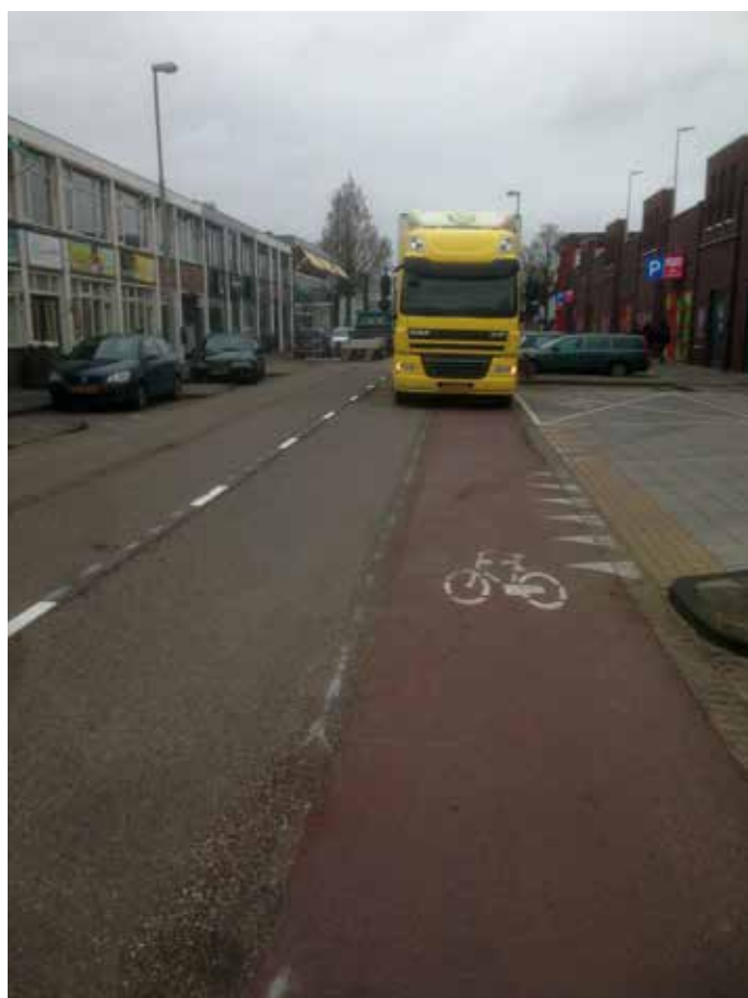
Foto boven: Stephensonstraat nieuwe situatie. Dwarsparkeren rechterkant; langsparkeervakken links zijn gehandhaafd; fietsstroken zijn weggefreed. Er wordt regelmatig geparkeerd door (vracht)wagens die laden en lossen. (Hier zelfs gelijktijdig aan beide zijden van de weg!). Het speciale laad- en losvak wordt lang niet altijd gebruikt.
