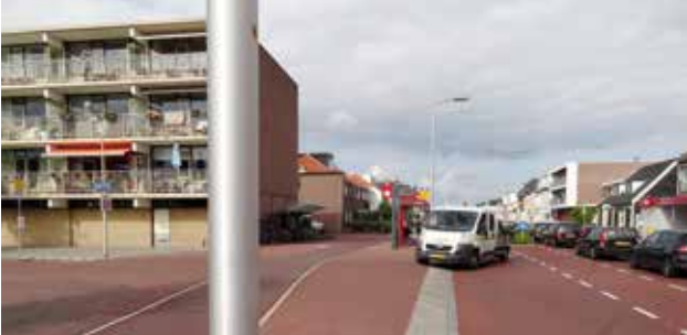
Bushalte Hagelingerweg: oude situatie - bij afslaand verkeer ontleemt abri zicht op fietspad
