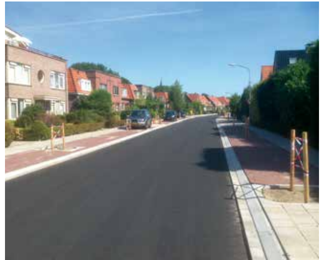
Vogelenzangseweg nieuw: In de asfalt toplaag komen 1.75m brede fietsstroken.
