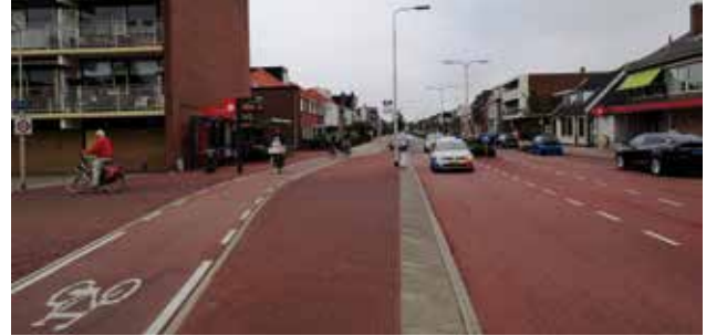
Bushalte Hagelingerweg: nieuwe situatie - abri is verplaatst naar de gevel.
