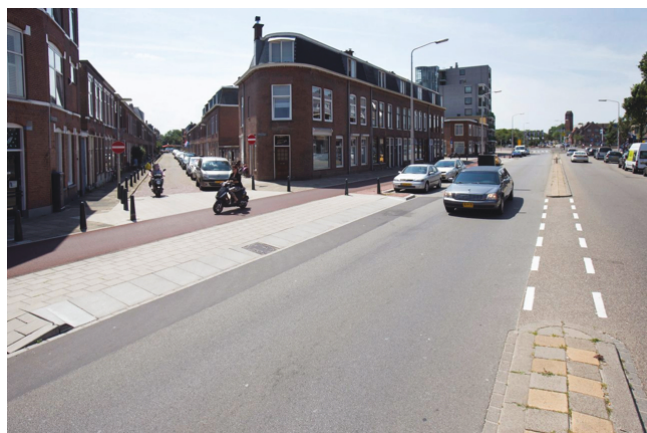
Figuur 26. Toepassing uitritconstructie met gebruik van inritblokken
