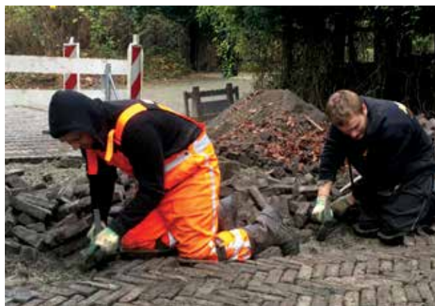
Met de hand, onder de hamer, worden de steentjes één voor één gestraat
