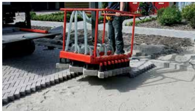
In een klem worden de klinkers neergevlid
