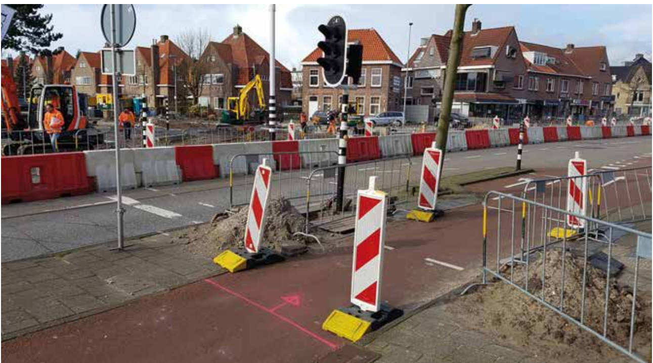
Werkzaamheden op kruising Rijksweg/Zaenenlaan/Zaenenstraat
