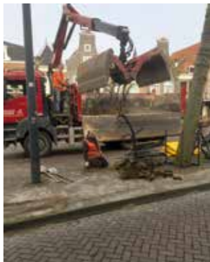
Eén voor één worden de 64 Tulips verwijderd
