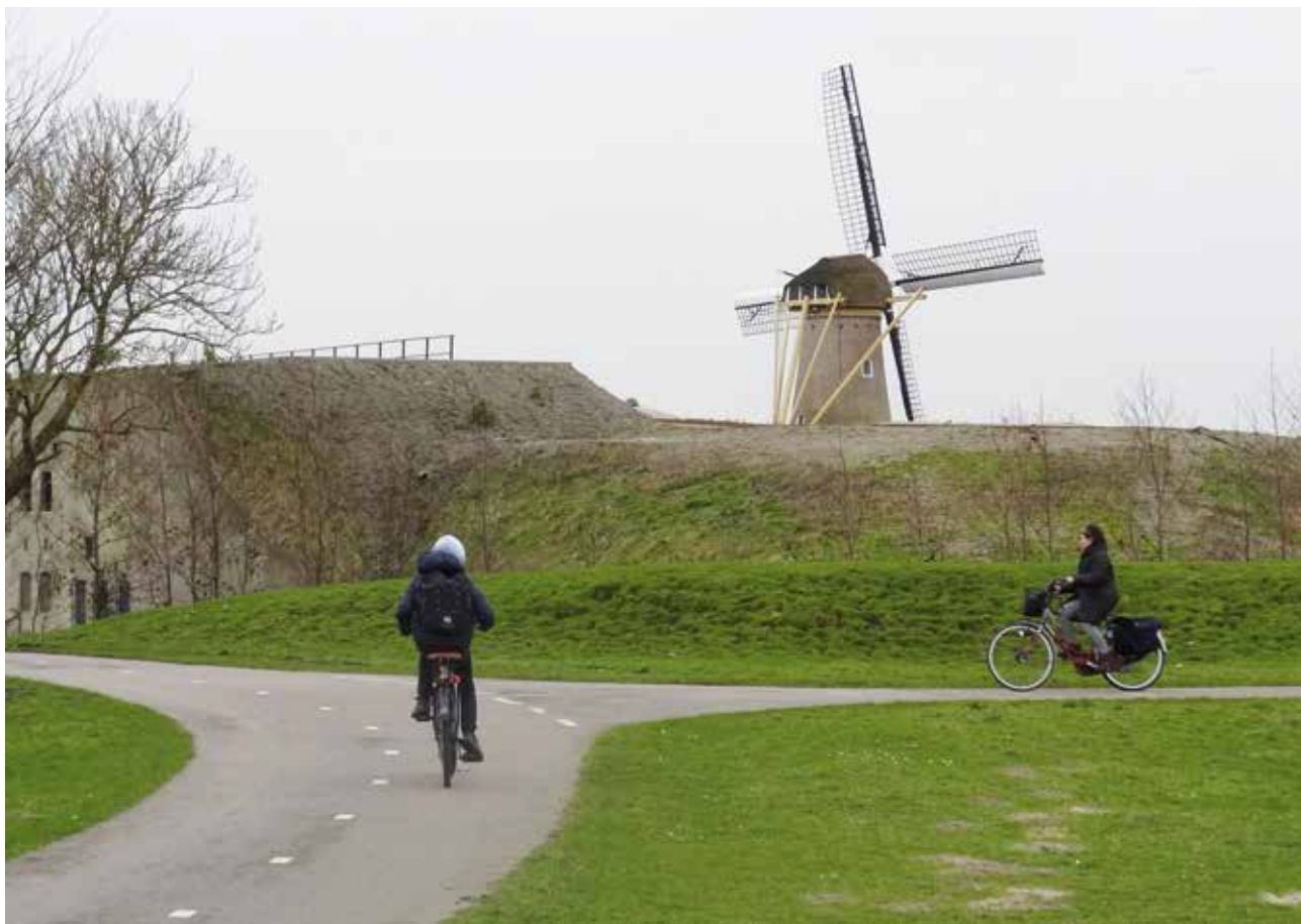
Geniedijk in Hoofddorp. De dijk is een doorgaande fietsroute (met uitzondering van de passage van station Hoofddorp) tussen Vijfhuizen aan de westkant en Rijsenhout aan de oostkant van de Haarlemmermeerpolder.
