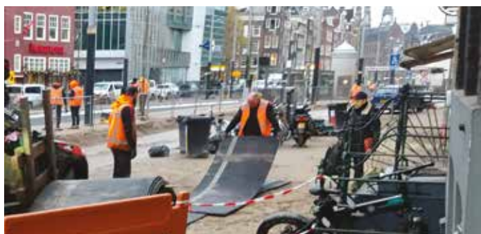
Voorbeeld van lichte, eenvoudig te verplaatsen rijplaten ('kluunmatten')
